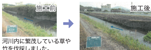
河道に堆積した土砂を維持管理上掘削しました。
